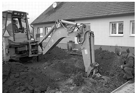
Výkopové práce pro přívod plynu.
