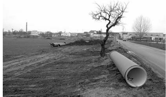
Navzdory nepříjemnému počasí práce probíhají tak, jak bylo předem stanoveno.
